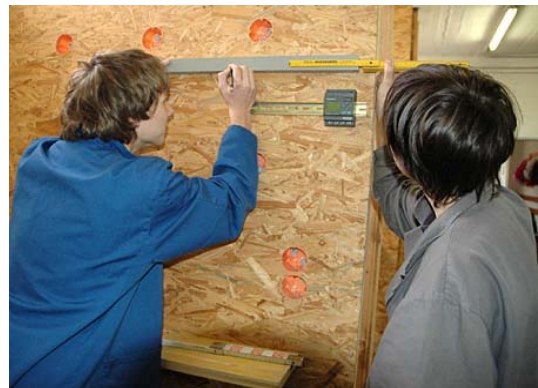
... anpassen der Kabelkanäle.
